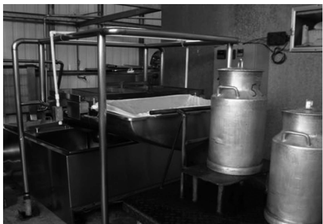
Figura 9. Recepción de leche en una planta de lácteos
