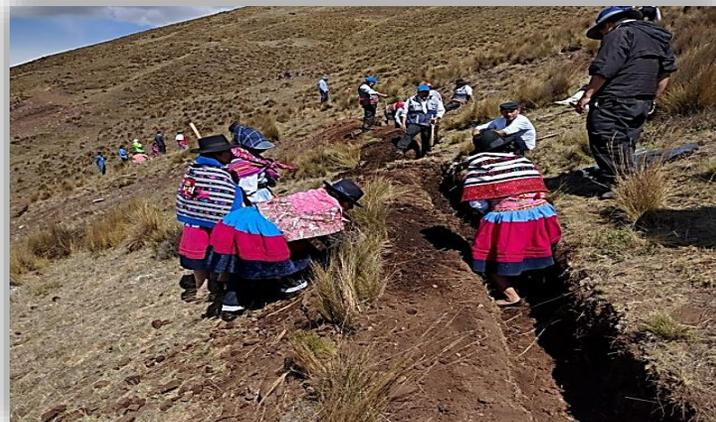
**2. ZANJAS DE INFILTRACIÓN**
